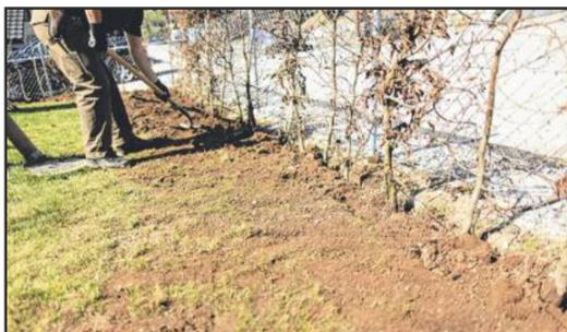
8. Voilà... Finissez de combler en ratissant le gazon et en formant une cuvette tout le long de la tranchée. Ça facilitera l'arrosage.
